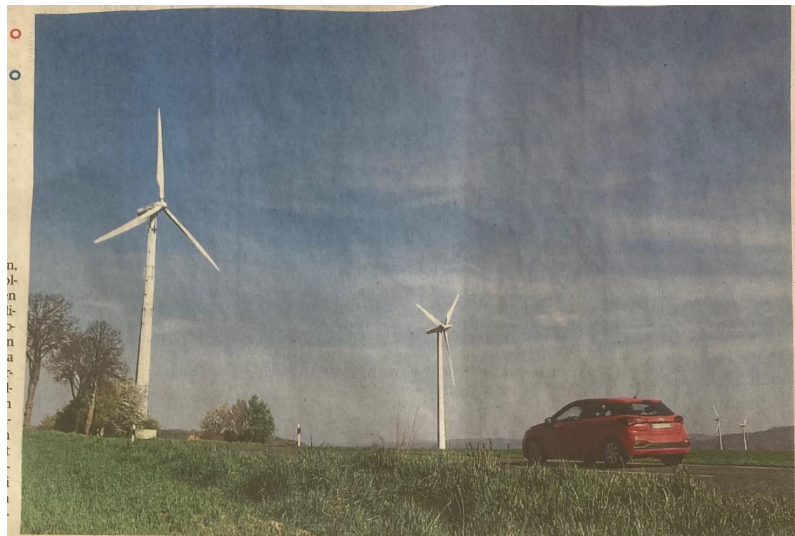
Diese zwei Windräder der Solling-Vorland GmbH und Co. KG nahe Imbsen sollen repowert werden.
